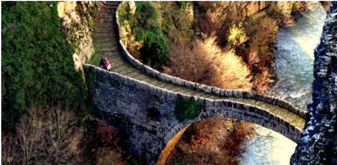
Photo: Kokkoros bridge.
